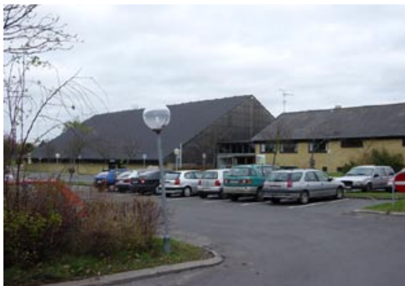
Lyng Idrætsanlæg set fra Idrætsvej
