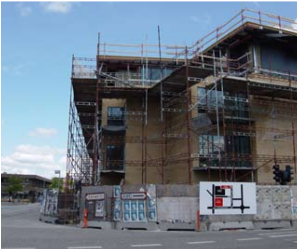
Boliger, butikker og parkeringskælder under opførelse på hjørnet af Lilledal og Frederiksborgvej
