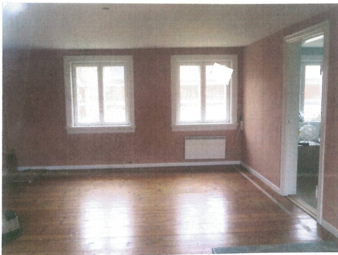
Et vindueskig til stue i stuehuslængen: Et ret smukt rum, der ville vinde betydeligt, hvis man fjernede det "moderne" glatte loft, og genskabte rummet med synlige bjælker, der må ligge ovenover. De ca 17 cm hjælper desuden på den begrænsede lofthøjde. 2015.
