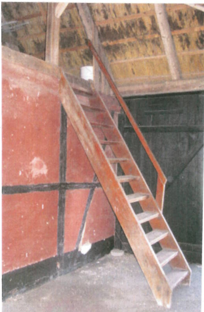
Vestlængens portrum med indbydende adgang til ubeskyttet loft. (Juni 2010)
