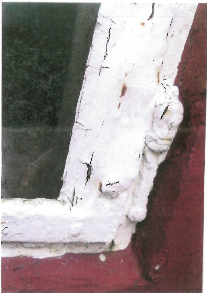
Detalje: hjørnebåndshængsel med overmalet, smedet rumpestabel fra 1800-tallet. (Apr.2015)
