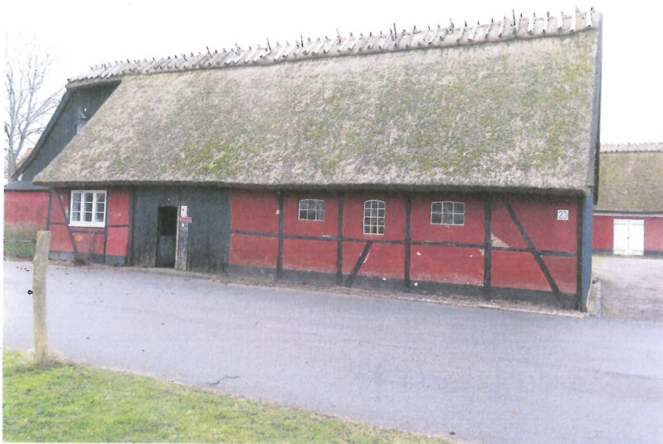
Vestlængens bindingsværk er noget forskåret af senere vinduesplaceringer. Skråbåndet i yderste fag th. antyder at længen ikke har været længere. (Apr.2015.)
