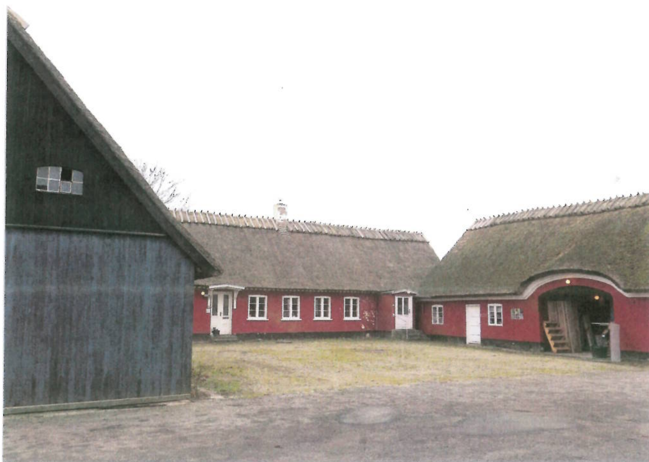
Gårdspladsen og vestlængens gavl er nok som reparation blevet bræddeklædt.(Apr.2015)
