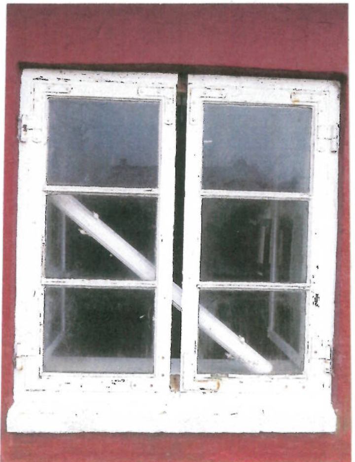
I vestligste vindue i stuehuslængen har man savet midterposten af, vel for at få noget stort igennem. (Apr. 2015.)
