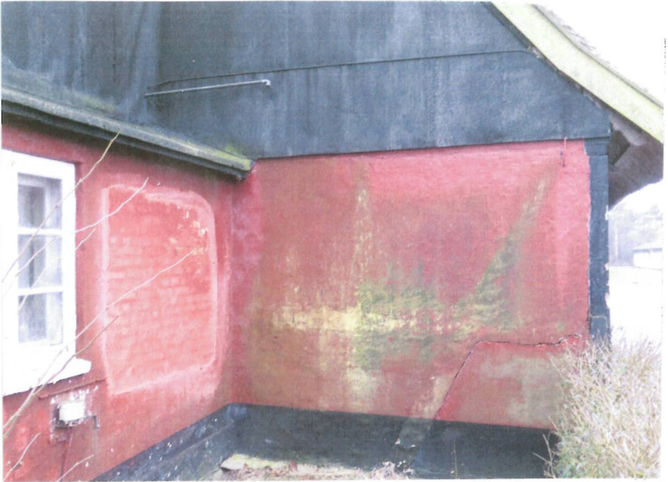
Sammenbygningen af stuehuslængen og vestlængen viser overpudset bindingsværk og et nyligt tilmuret vindue. (Apr.2015.)
