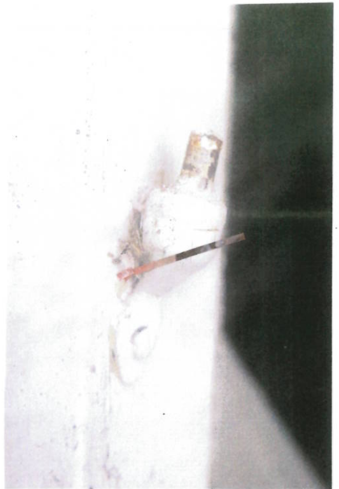
Smedet anverferkrog i stuelængen. (Apr. 2015)
