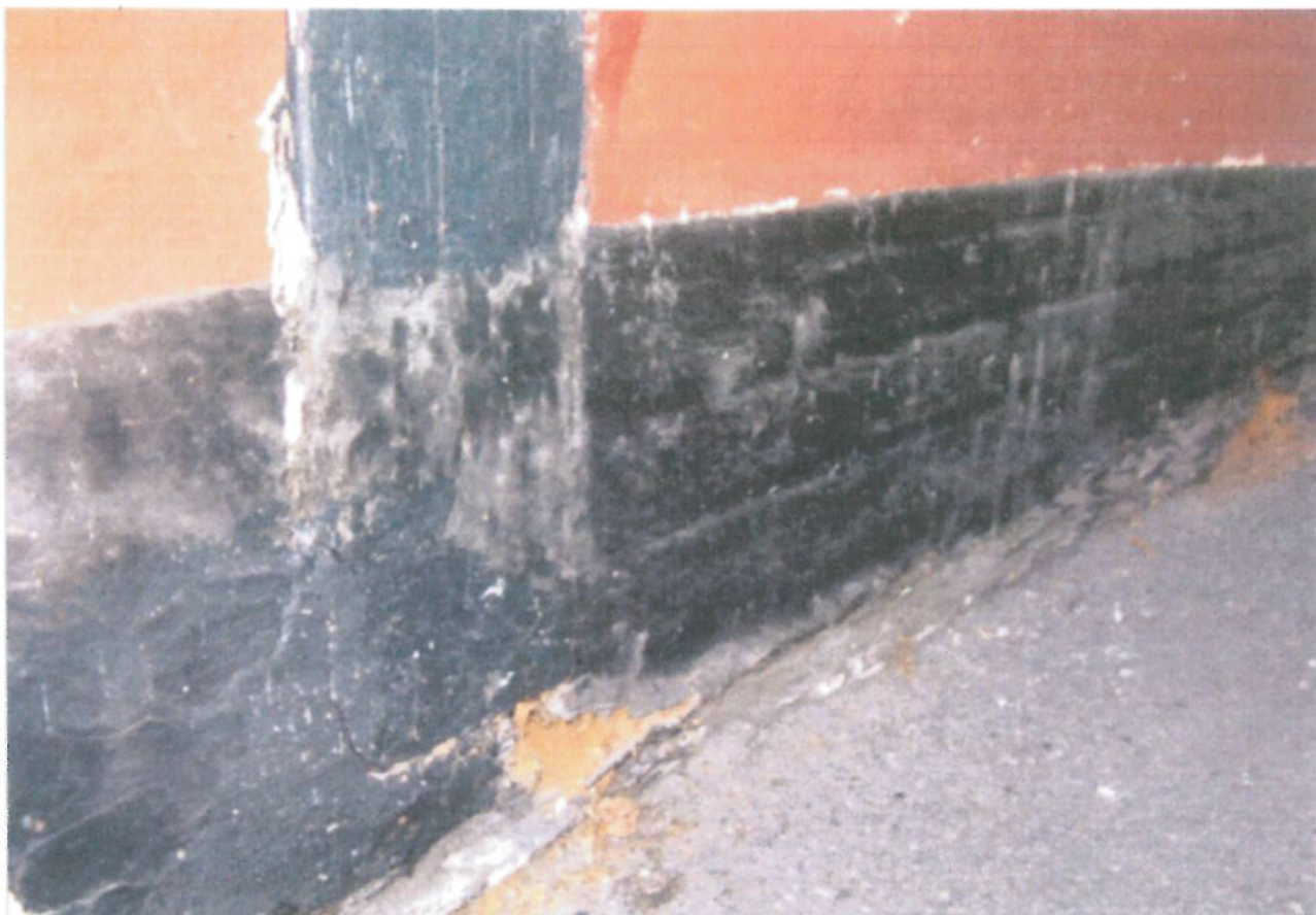
Portrummets fodrem i vestlængen er mest smulder. Tjærelaget redder ikke stabiliteten. Juni 2009
