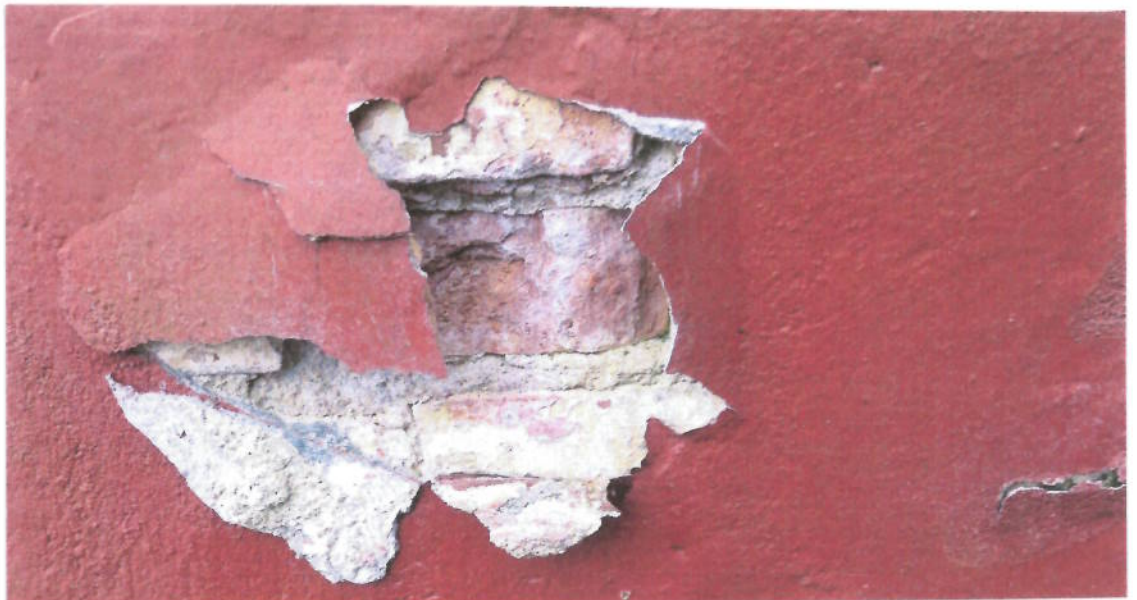
En klassisk fejl: stærk maling på gammel, svag kalkbund.
